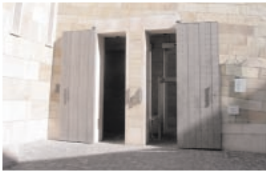
Die Eingangstüren der Gedenkstätte erinnern bewusst an die Türen der Gaskammern.
